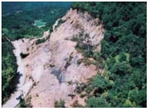
箕浦地区の土砂崩落の様子
